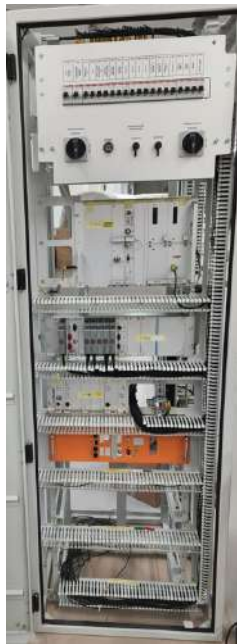
Rozvaděč s částmi ETCS
