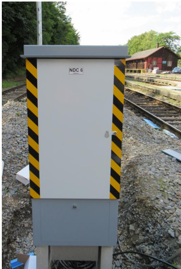
Skříně objektových kontrolérů Humpolec
