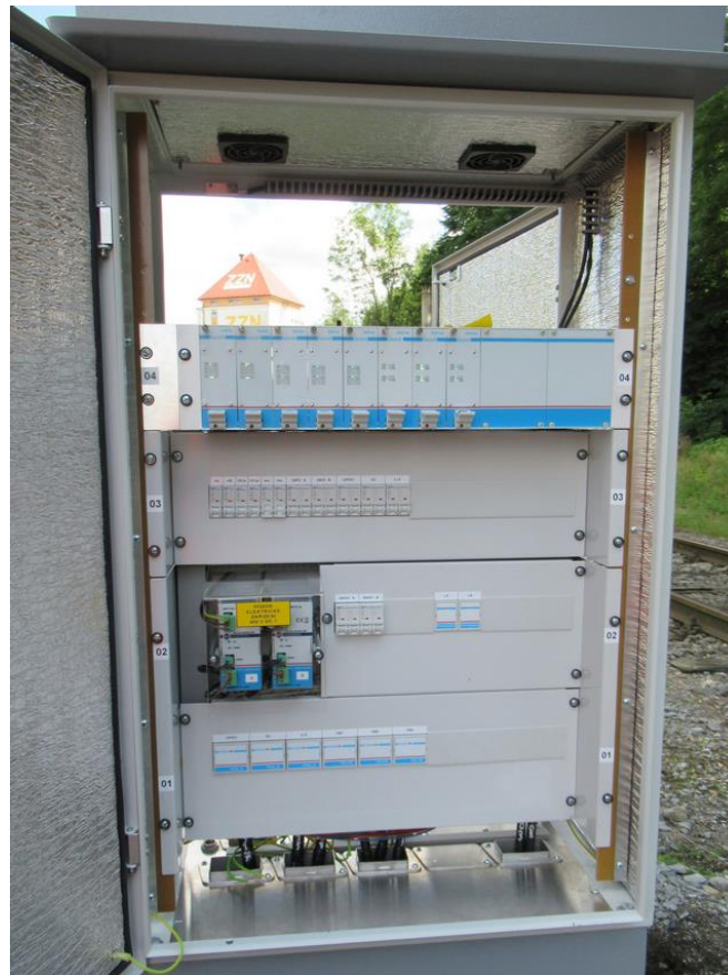
Skříně objektových kontrolérů Humpolec
